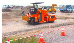
再生砕石による基礎盛土の施工
