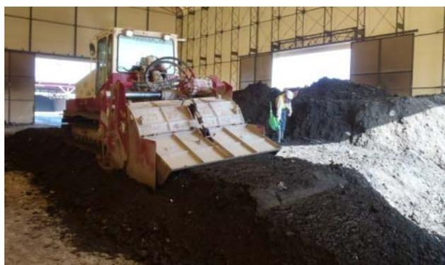
写真-22 スタビライザーによる攪拌混合
