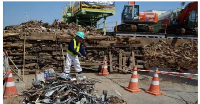
写真-11 手選別による金属類の撤去
