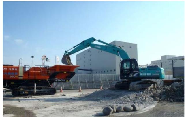
写真-17 コンクリートガラ破碎状況
