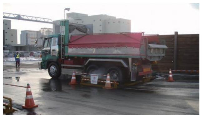
写真-29 タイヤ洗浄設備
