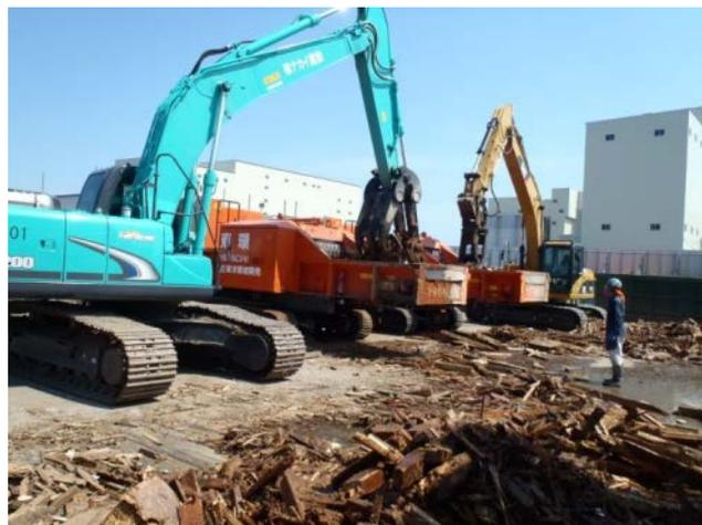
写真-13 木材破砕機による破砕
