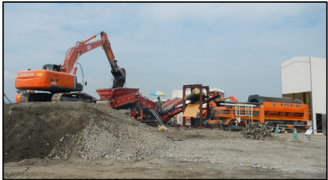
写真-9 津波堆積物の選別状況
