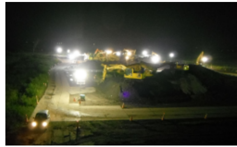
写真-10 夜間作業状況
