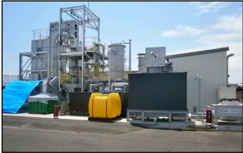
写真-6 木質バイオマスガス化発電
