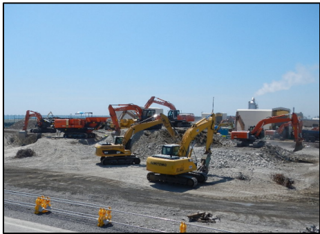
写真-8 コンクリート破碎
