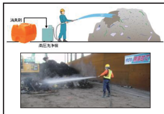
図-10 消臭剤噴霧による対策状況
