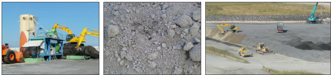
主灰固化プラント
