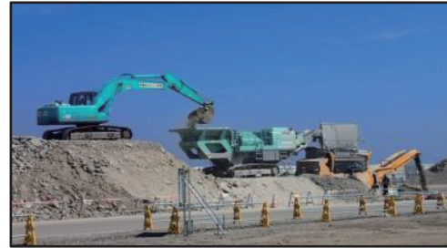
写真-7 コンクリートがら破砕状況
