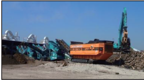
写真-6 木くず破砕状況
