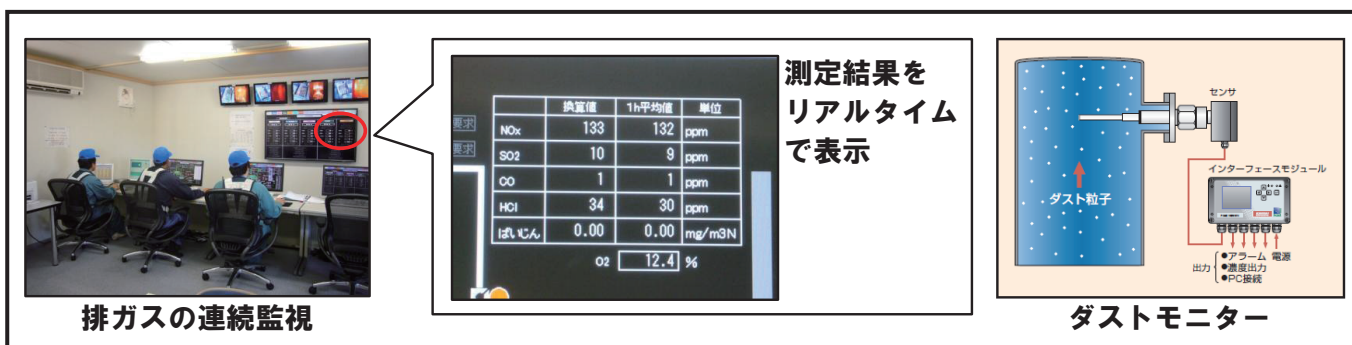
図-11 焼却炉排ガスの連続監視
