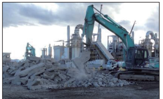
写真-13 コンクリート基礎等の撤去状況
