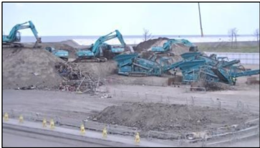
写真-10 津波堆積物の選別処理状況
