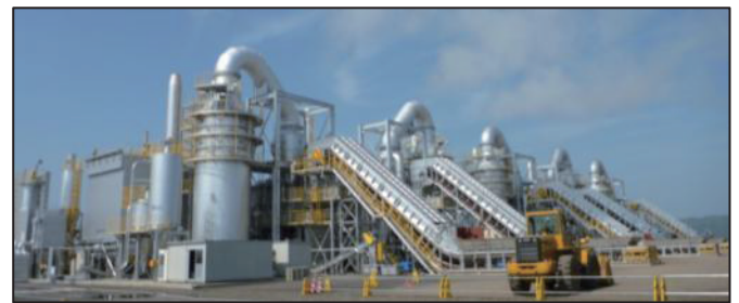
写真-8 焼却施設(全景)
