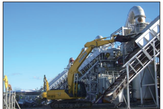
写真-12 焼却炉の解体状況
