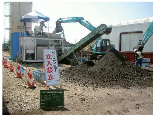
写真-12 造粒固化処理状況
