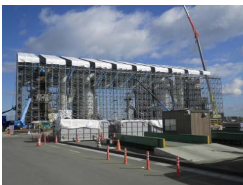
写真-12-1 全覆いテント設置状況
