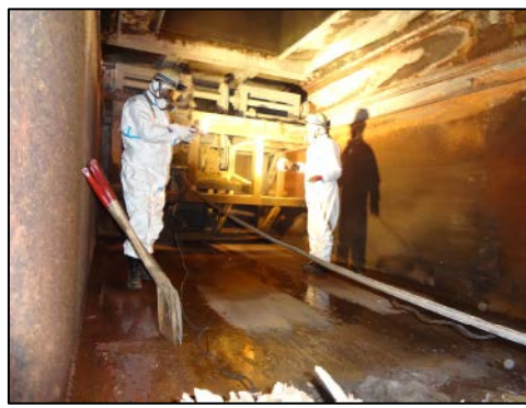
写真-7-2 炉内清掃(定期点検)
