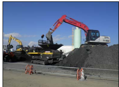
写真-13-2 固化後再破碎状況
