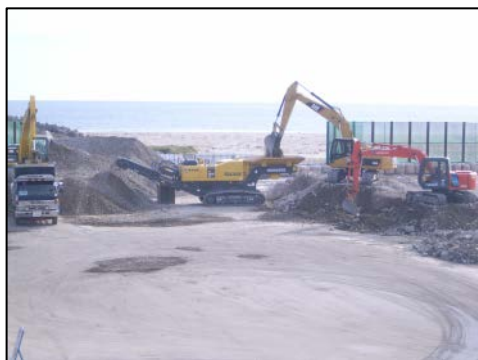
写真-5 コンクリートガラ破砕状況
