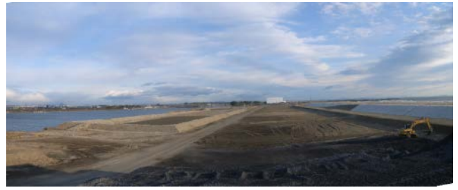
写真-12-6 閑上一次仮置場整地復旧完了
