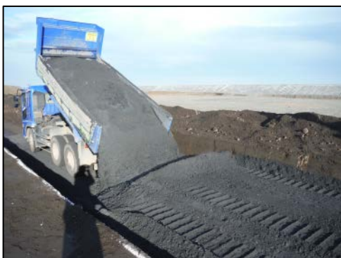
写真-13-3 固化材再利用状況
