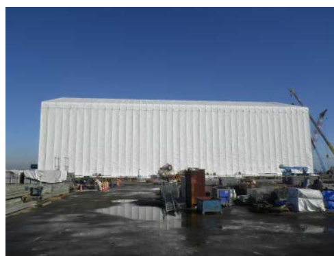
写真-12-2 全覆いテント設置完了
