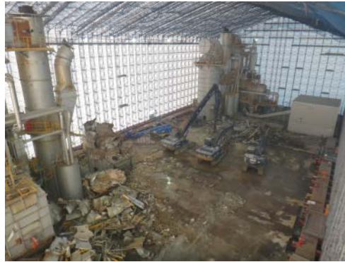
写真-12-4 焼却炉の解体状況(2)
