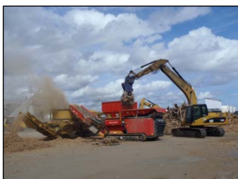
写真-4-1 木くず破砕状況
