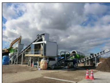
写真-9-3 農地粘性土処理 (三軸パドル式混練機)
