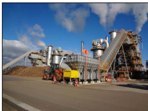
写真-7-1 稼働中の焼却炉
