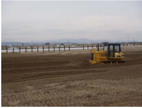
写真-12-5 二次処理ヤード整地復旧状況
