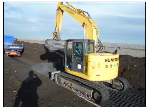
写真-13-4 固化材再利用状況
