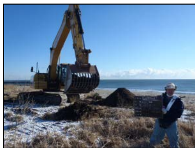
写真-9-1 津波堆積物篩い(スケルトンバケット)
