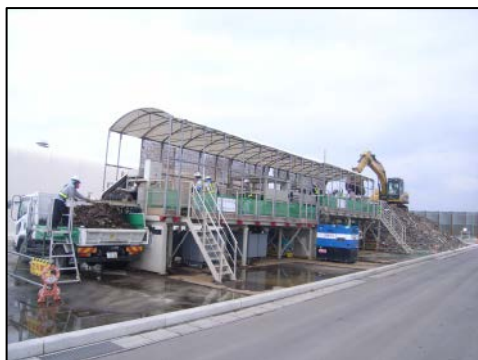
写真-3-1 選別施設
