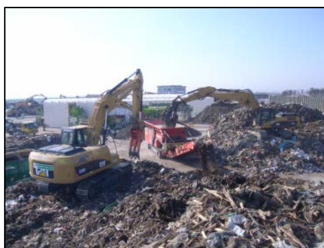
写真-6 混合がれき破砕状況
