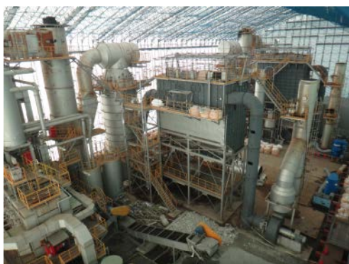
写真-12-3 焼却炉の解体状況(1)
