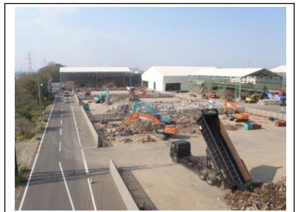
写真-1 受入・重機選別状況
