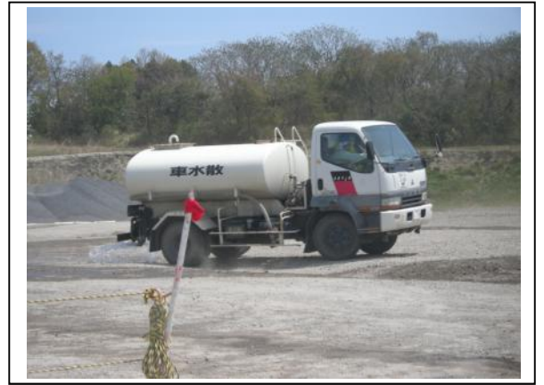
写真-16 散水車使用状況
