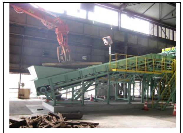
写真-5 木くず破砕状況
