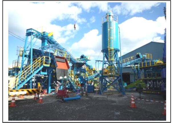
写真-9 主灰造粒固化設備
