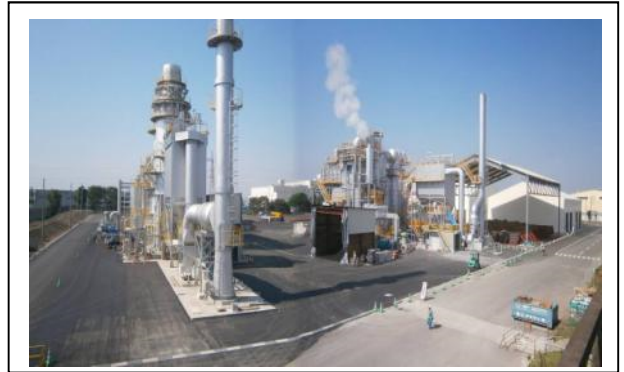
写真-6 稼働中の焼却炉
