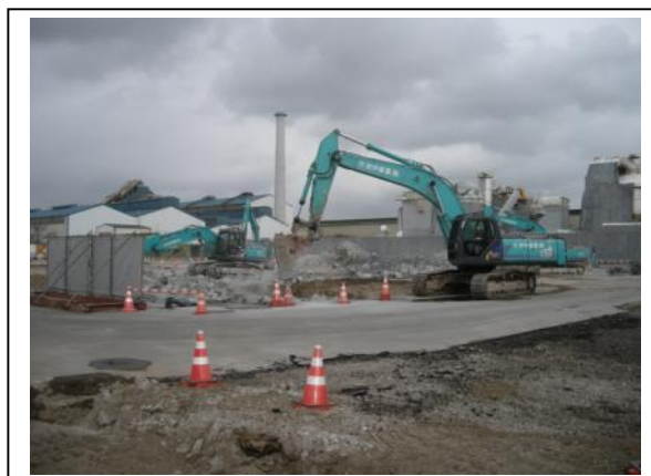
写真-14 復旧作業状況
