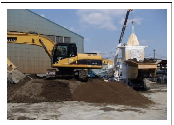
写真-8 選別土砂不溶化状況
