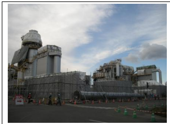
写真-13 焼却炉の解体状況
