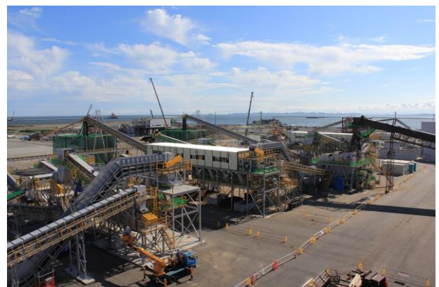
写真-4 破碎選別施設
