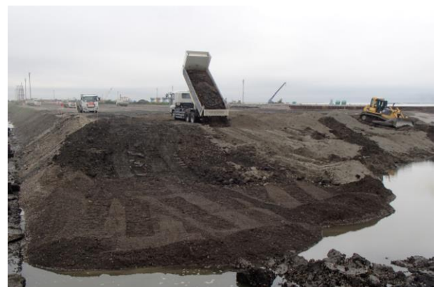
写真-12 港湾埋立柱状況
