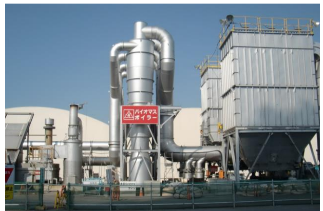
写真-8 バイオマスボイラ
