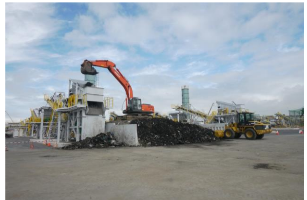
写真-10 土質改質施設
