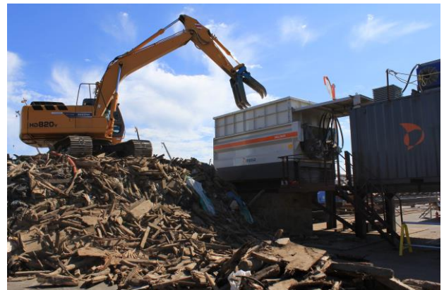
写真-3 粗破碎機投入作業
