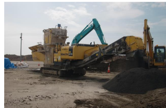
写真-14 汚泥固化処理状況
