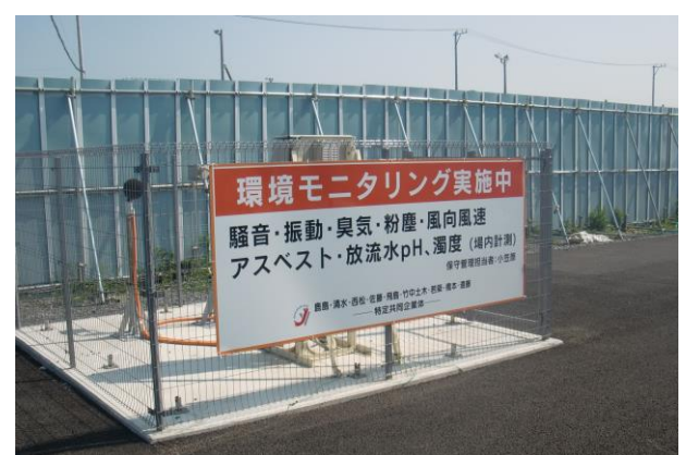
写真-15 環境モニタリング状況
