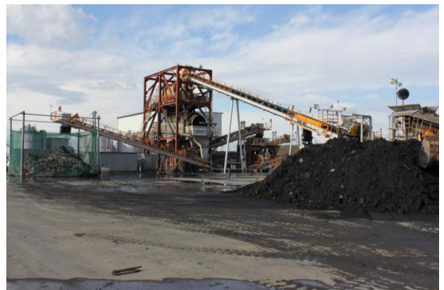
写真-11 土壤洗浄施設
