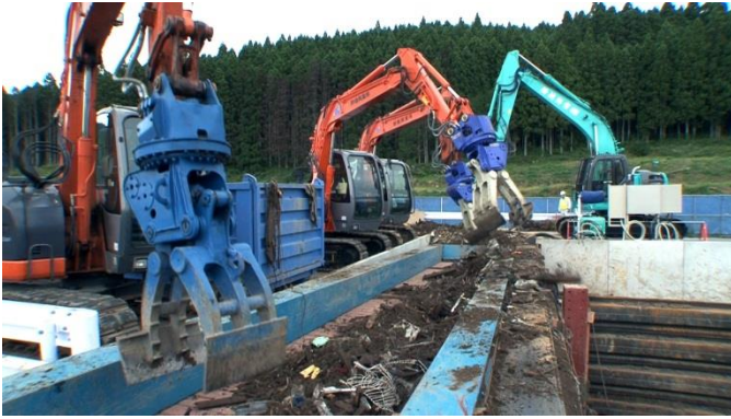
写真-4 重機選別の状況
