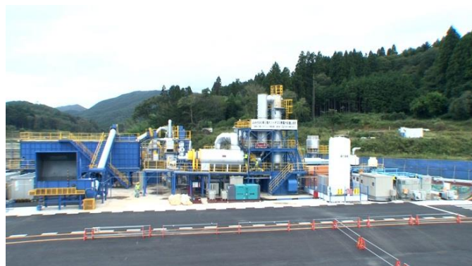
写真-14 木質バイオマス発電施設
