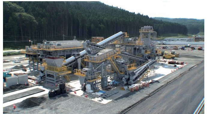
写真-15 土壌洗浄施設
