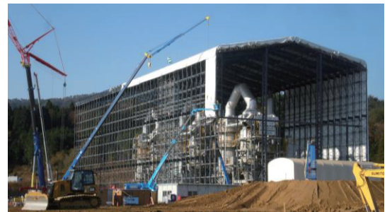
写真-17 焼却炉にテントを設置中の状況
