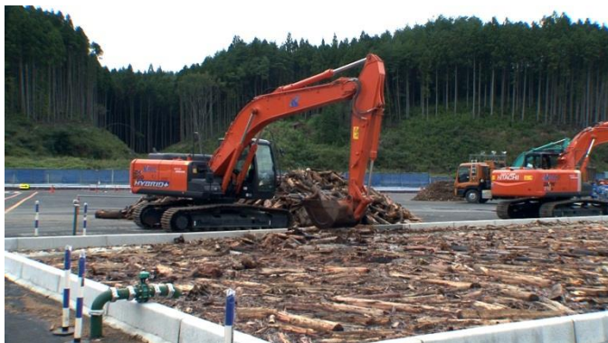
写真-10 木洗浄状況
