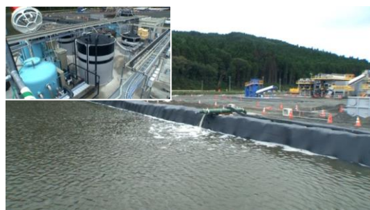
写真-21 スーパー調整池と排水処理施設
