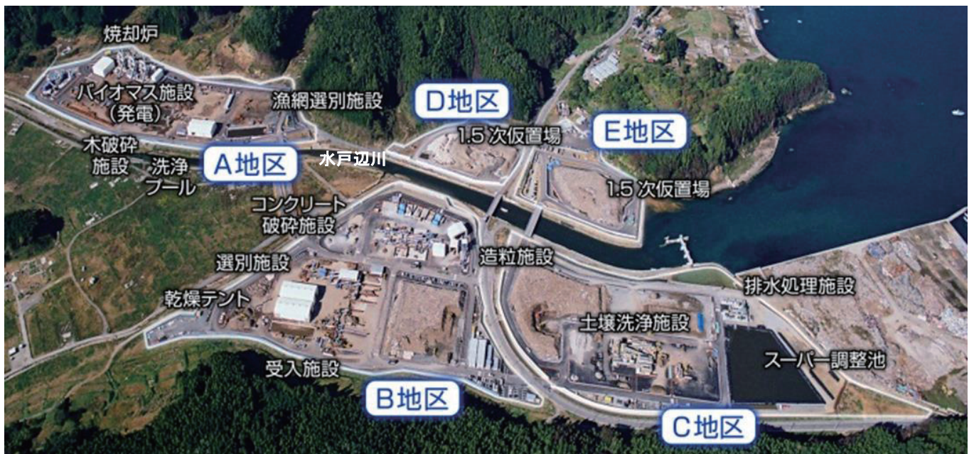
図-1 二次仮置き場の施設配置
