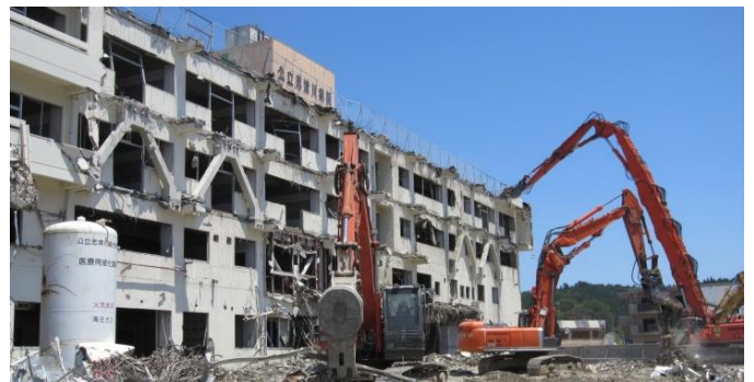
写真-1 RC 建築物解体状況
