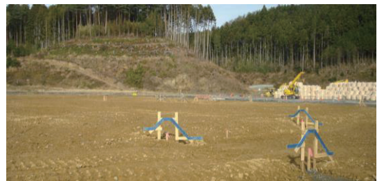
写真-18 原状復旧中の状況
