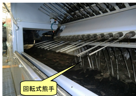
写真-2 可燃物と不燃物の分離状況
