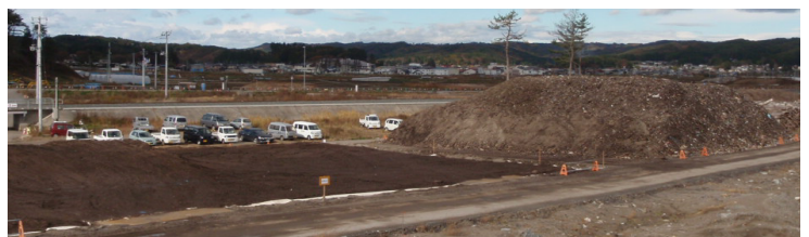
写真-3 不燃物保管状況
