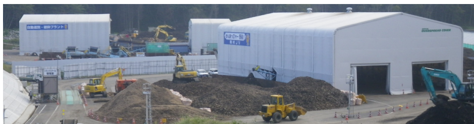
写真-1 二次仮置場全景(米田)
