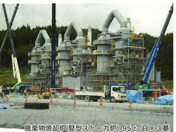
梅雨とはいっても今年は比較的長雨が少ない日々が続いている中、南三陸町の廃棄物処理を行う施設の工事が4月からスタートし、3か月半が過ぎようとしています。施設の中心である焼却炉の建設工事はほぼ外部の組立を完了し、今後は内部の仕上げと外部の配管等の工事となります。現場は昼夜二交替で頑張っています。焼却炉は垂直ストーク炉タイプで一日95tを焼却可能な炉を3基建設中です。高さは25メートルと国道398号線からでも望めます。
