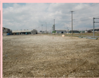
一次仮置場の搬出完了状況(魚町西公園)
