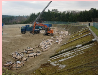
大崎広域処分場での飛灰の積下し状況
