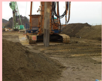
地盤改良工事に使用される再生砂(写真左)
