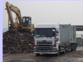
最終日のコンテナ積み込みの様子(北九州市)
