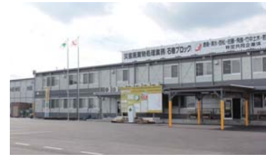
JV事務所全景
