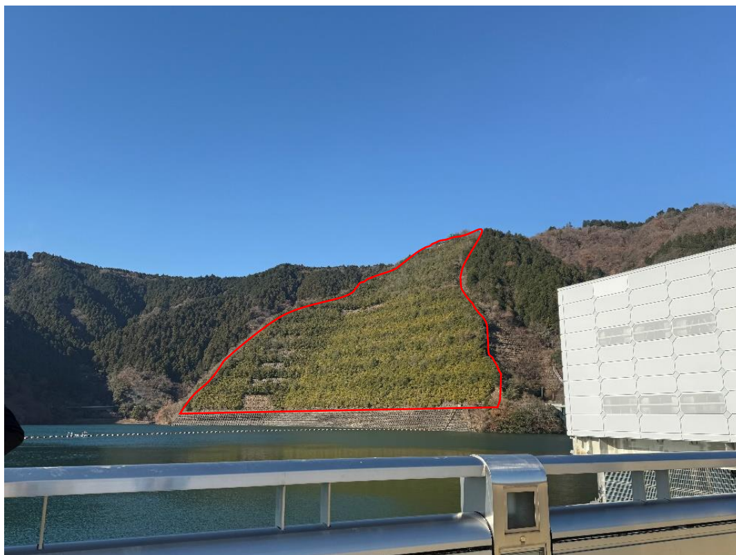
写真 5-2.1 宮ヶ瀬ダム原石山法面緑化（令和 6 年 12 月撮影）
