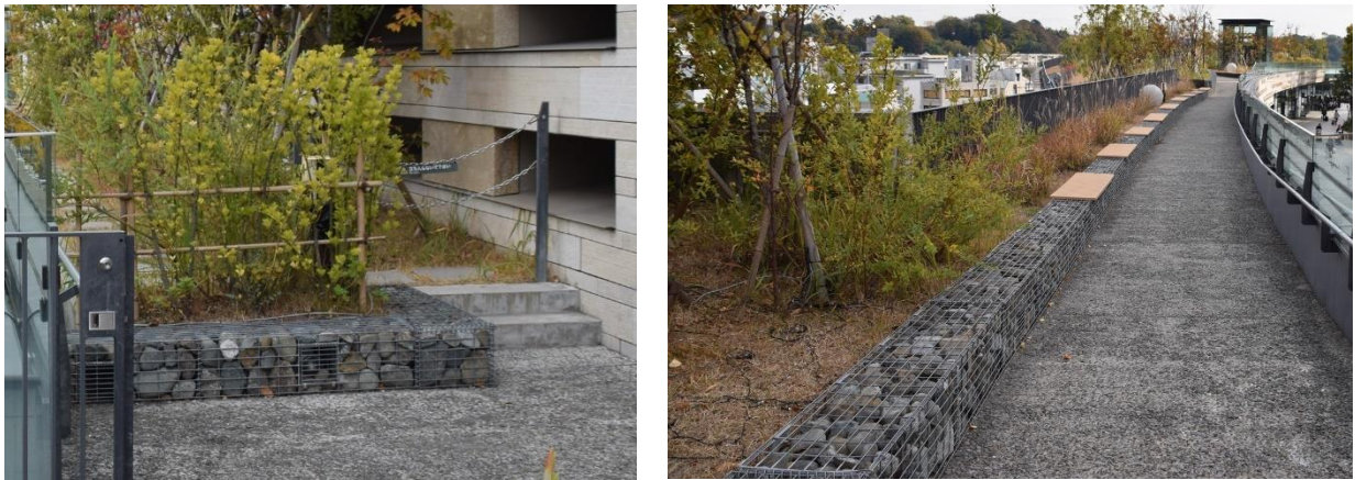
写真5-3.2 現地で発生した砂利が使用された舗装、蛇籠
