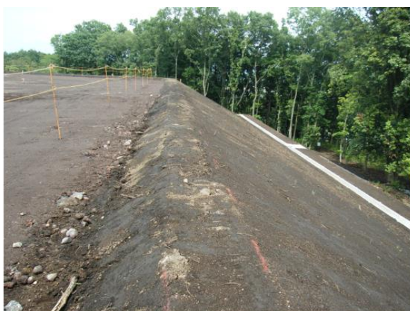
一般的になされる均一な法面整形
