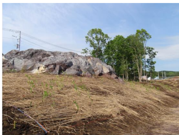
既存林や既存岩を保全した法面整形
