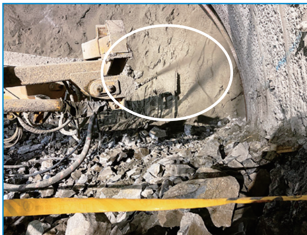
吹付け施工状況
