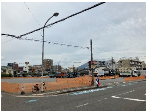
図-11 待機場（モータープール）全景
