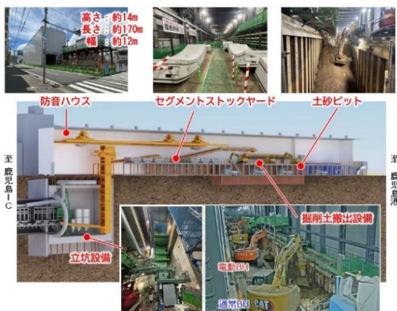
図-3 シールド発進基地
