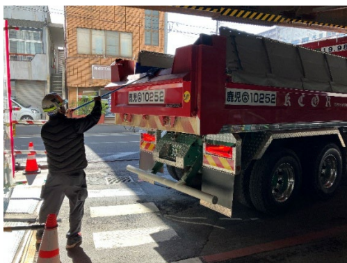
図-5 場外搬出前清掃状況
