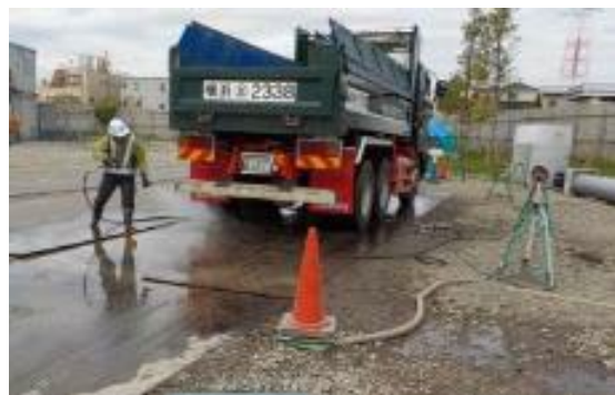
写真-5 ダンプトラックタイヤ清掃状況
