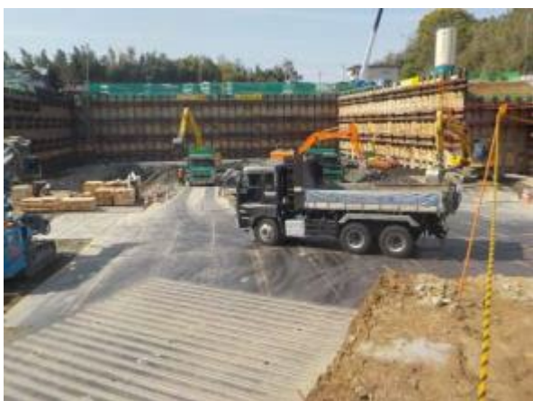
写真-9 敷鉄板設置
