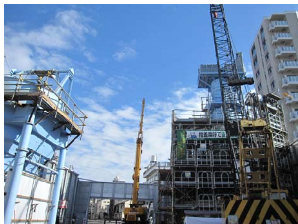
工事現場状況
