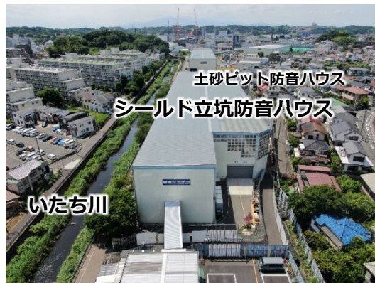
写真 1：シールド作業基地ドローン撮影
