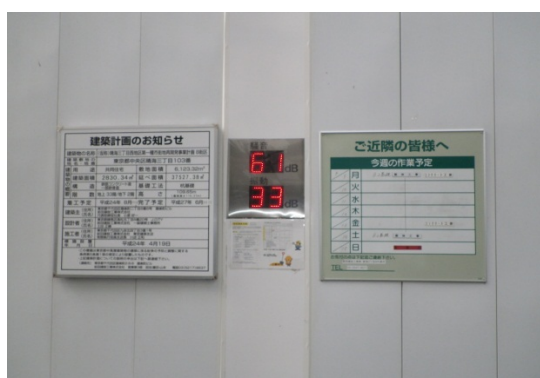
仮囲いに騒音・振動計の標示
