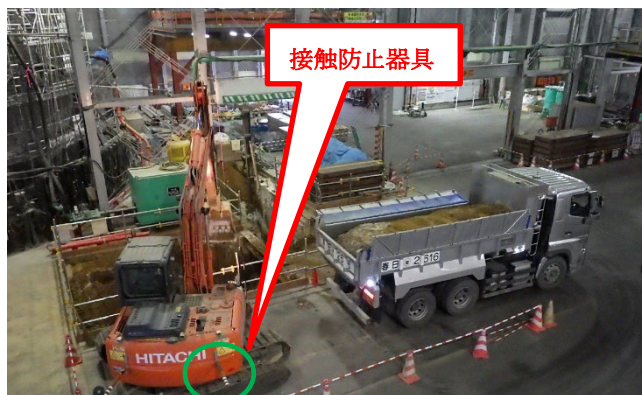
重機周り区画明示
