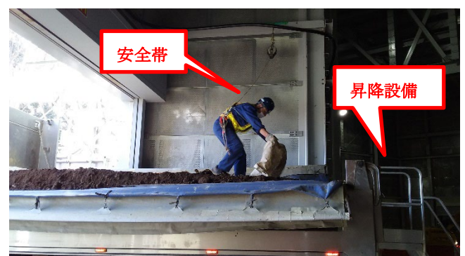
ダンプシート掛け状況
