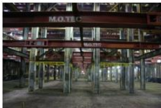
平成23年9月 掘削完了
