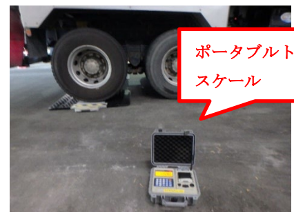
ダンプ荷重確認状況
