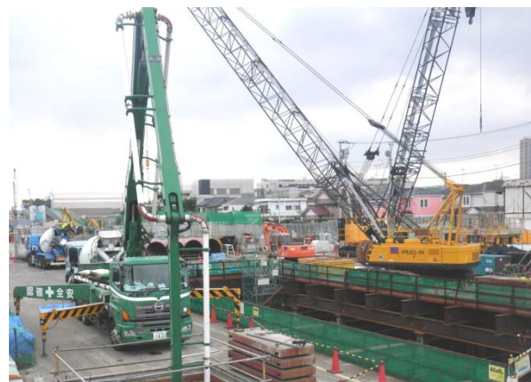
工事現場状況1（地上）
