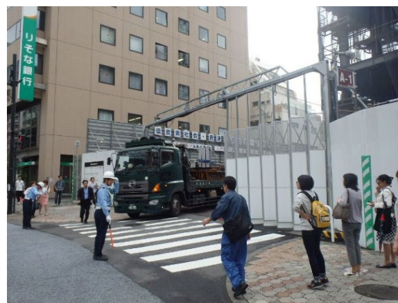
車両誘導状況
