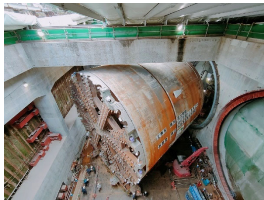
写真 7：シールド機の引抜・回転作業
