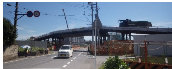
県道架空横断栈橋
