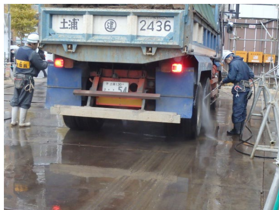
タイヤ洗浄状況
