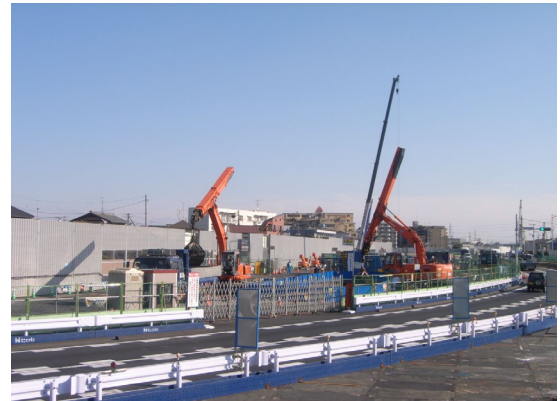
田尻地区函渠工事全景
