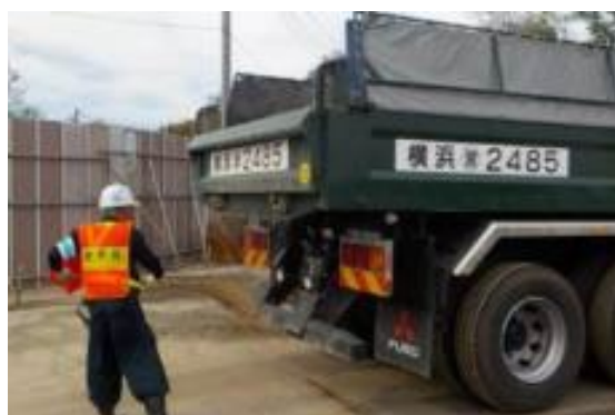
写真-6 ダンプトラック荷台背後清掃状況
