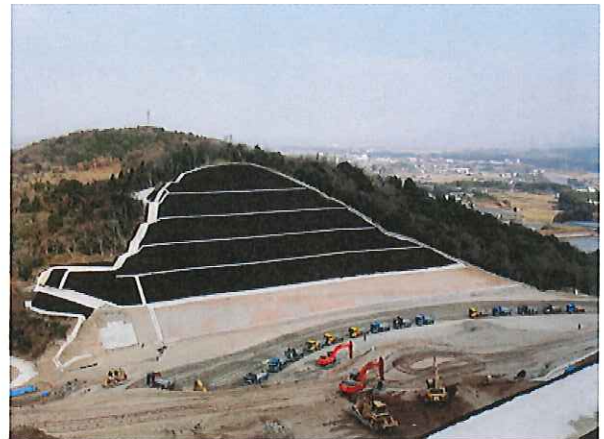
工事進捗状況
