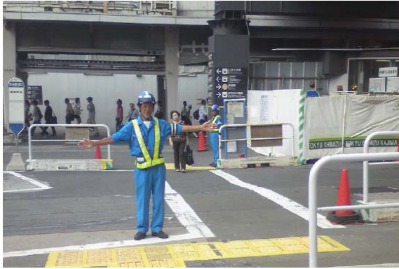
写真－１ 仮設横断歩道誘導状況
