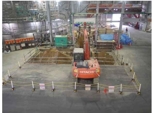
防音ハウス内施工状況
