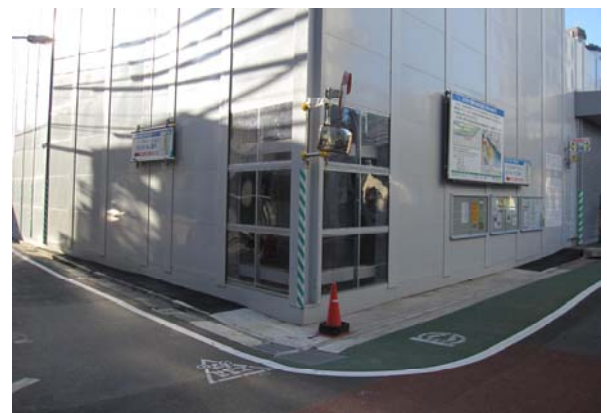
クリアパネル設置状況
