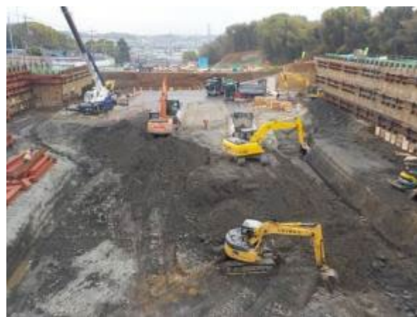
写真-1 掘削工施工状況
