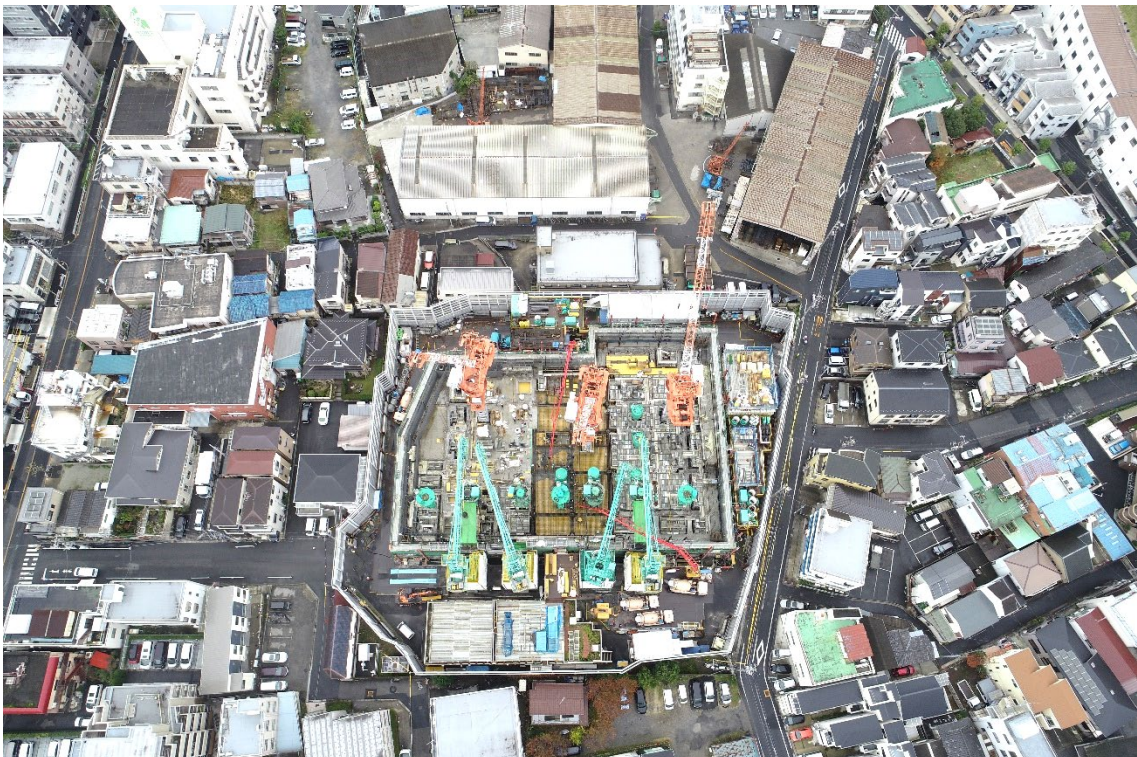
写真-1 掘削工施工状況
