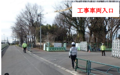
交通誘導員配置状況(通常時)
