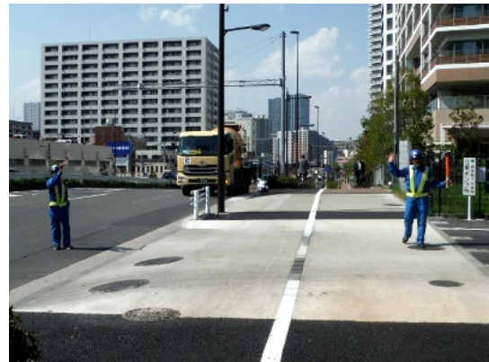
交通誘導員配置状況
