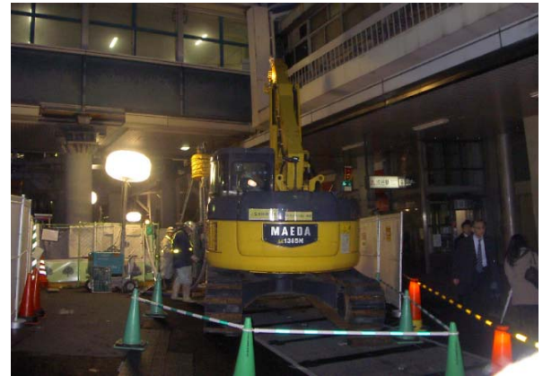
写真－８ フェンスによる通路の明確化
