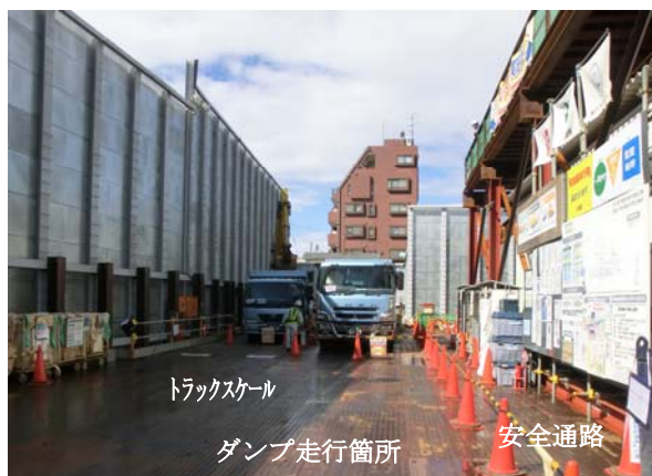
残土積み込み状況
