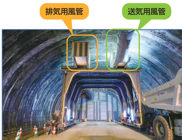
坑内から坑口方向を撮影
