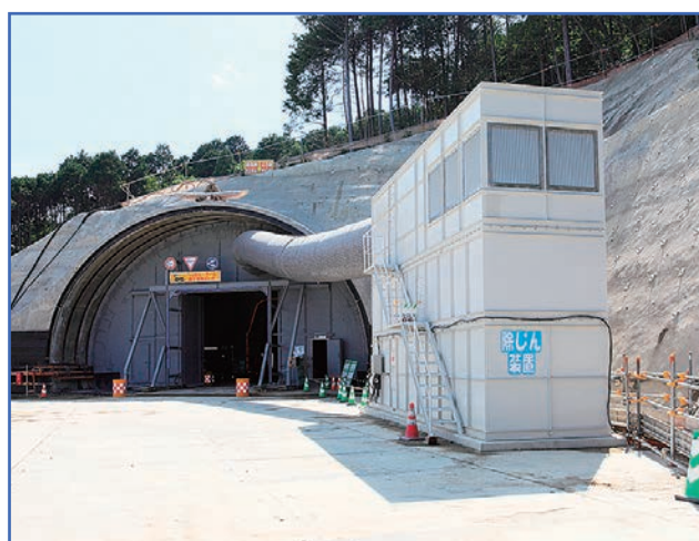
坑口部の除じん機
