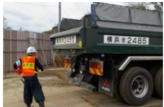
写真-6 ダンプトラック荷台背後清掃状況
