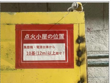
写真9. 点火場所の設置位置の基準明示(消費場所)
