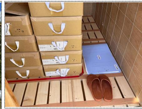
写真5. 床面全面にスノコ設置。内面からの赤色テープ明示(30cm以上の離隔明示)(火薬庫)
