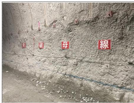
写真8. 発破母線明示(消費場所)
