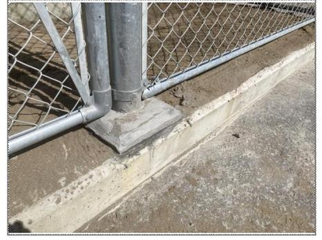
写真3. 外柵支柱固定用ボルトのモルタル養生
