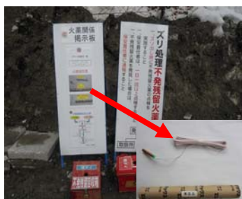
不発残留火薬写真入処理明示
