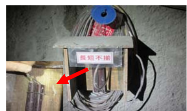
発破母線塩ビ管防護
