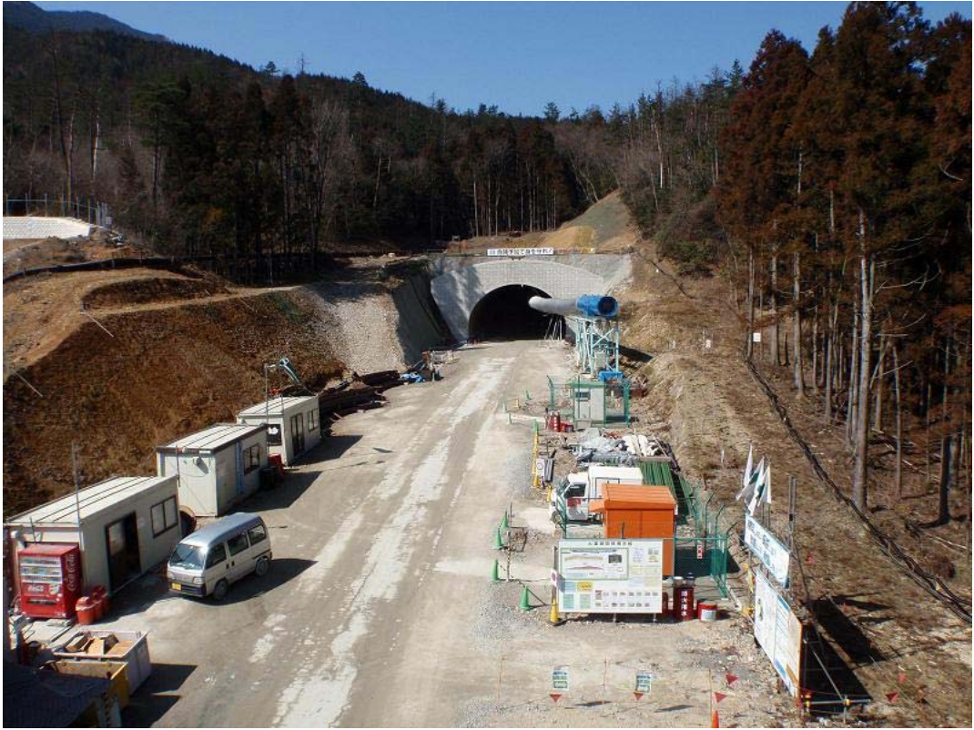
【別所トンネル和田山側坑口全景】
