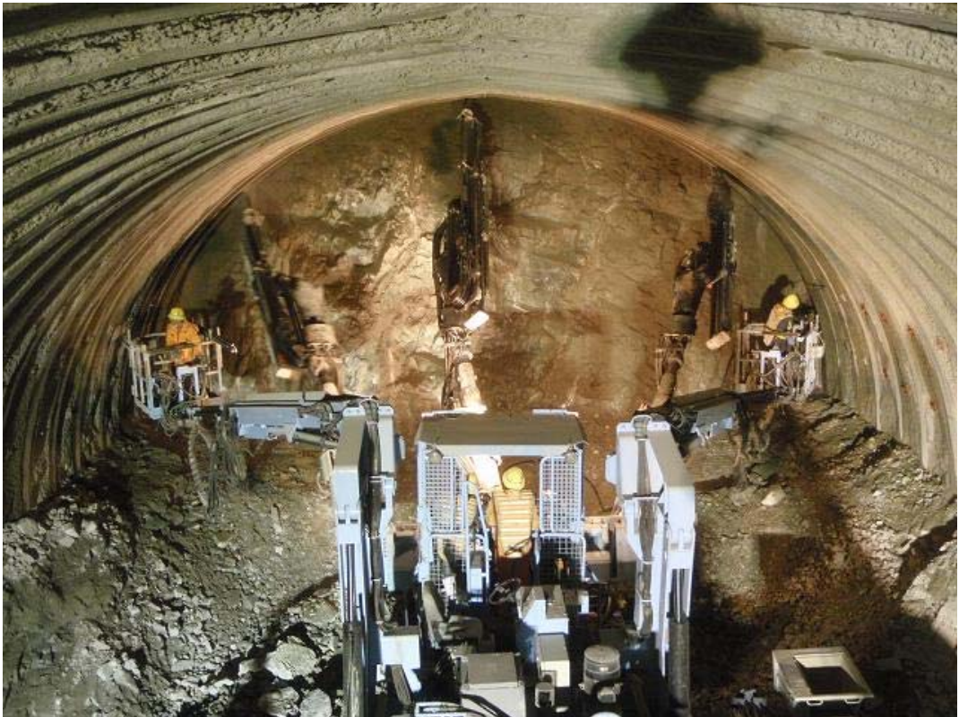
【別所トンネル掘削状況】
