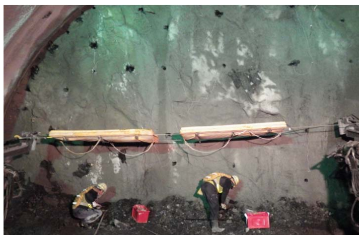
装薬状況(落石防護バルーン)
