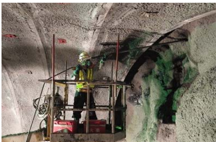
装薬状況(爆薬の遠隔装填システム)
