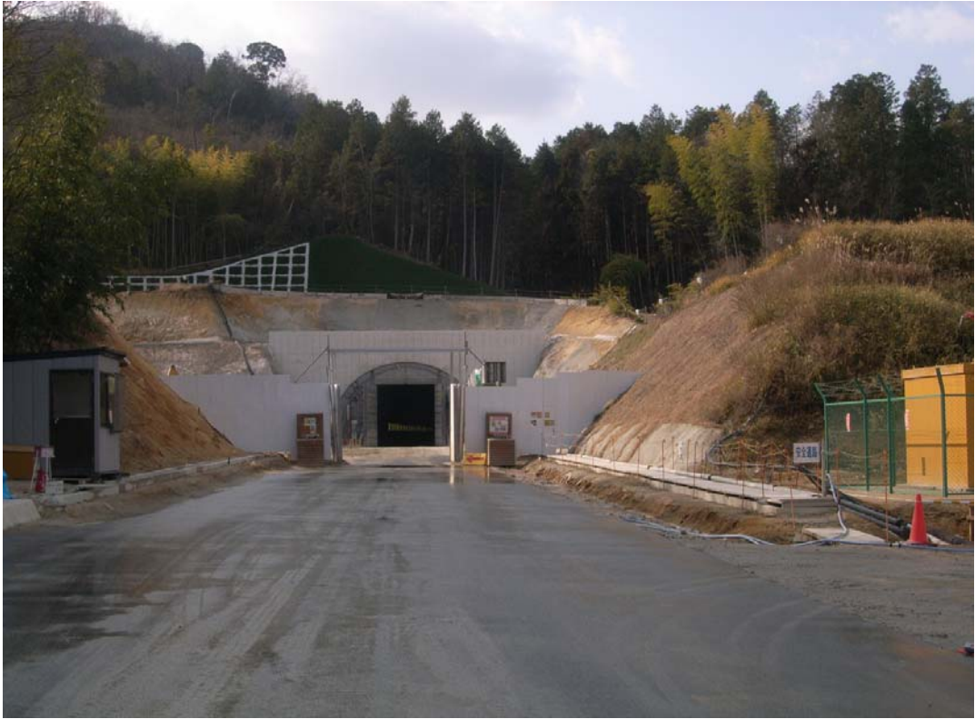
【岩山トンネル黒瀬側坑口全景】
