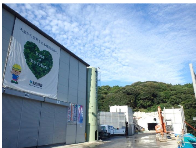
仮設ヤードから坑口を望む
