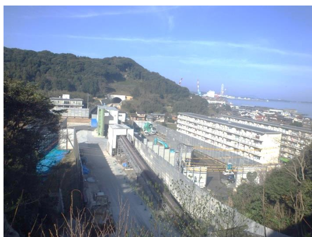
坑口上部から仮設ヤードを望む
