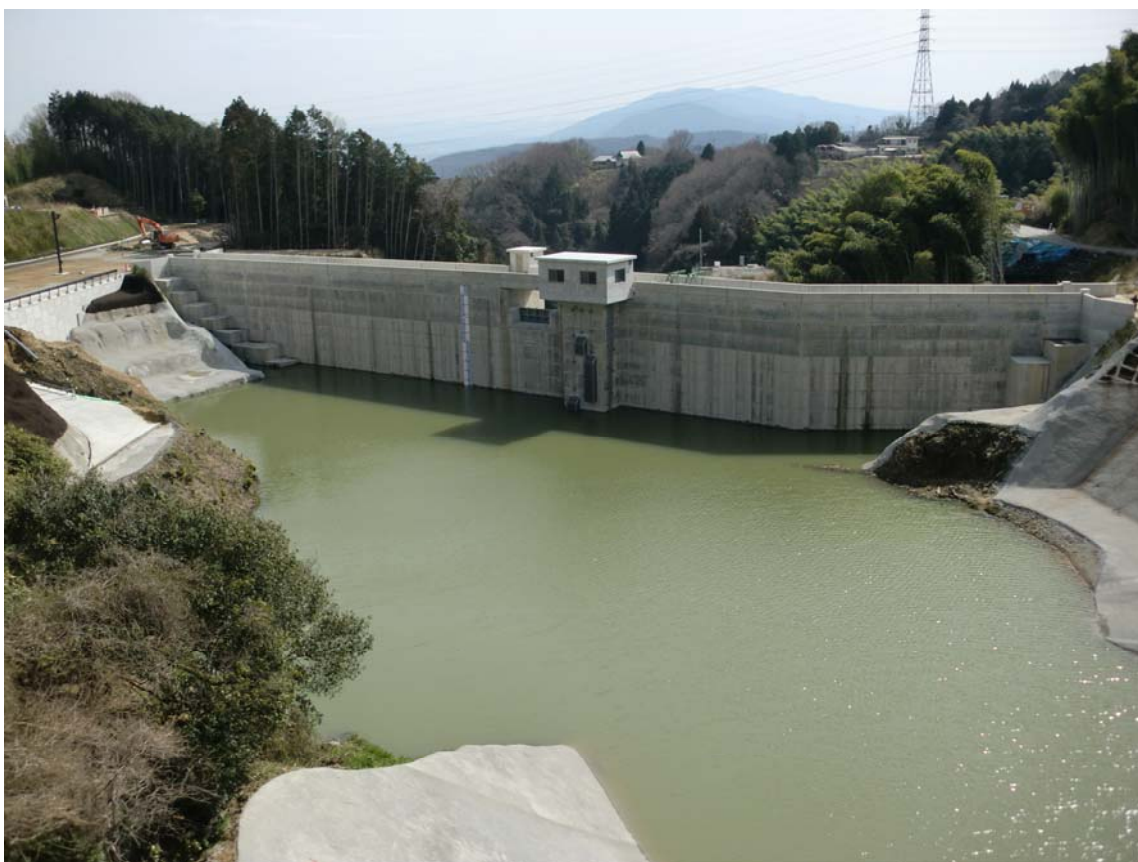
大門ダム上流より全景
