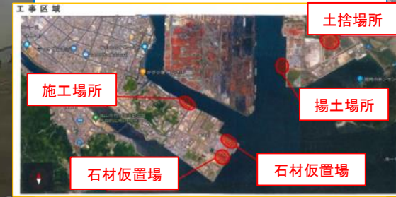
作業箇所が点在する現場
