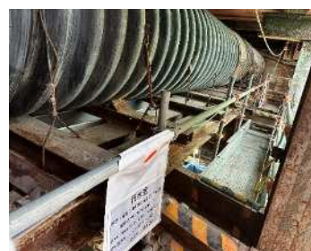
写真-3 雨水受け防護状況
