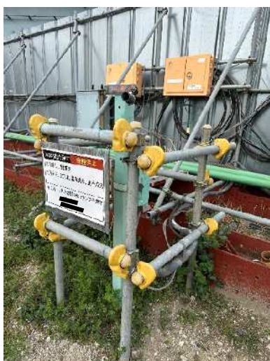
写真-4 雨水函渠に取り付けた 水盛式沈下計及びプリズム
