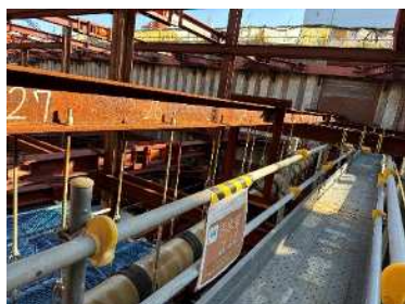
写真-2 汚水吊り防護状況
