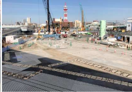
写真-7 ARによる地中連続壁 施工場所の可視化
