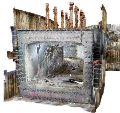
図-8 施工中の京葉 JCT の点群データ
