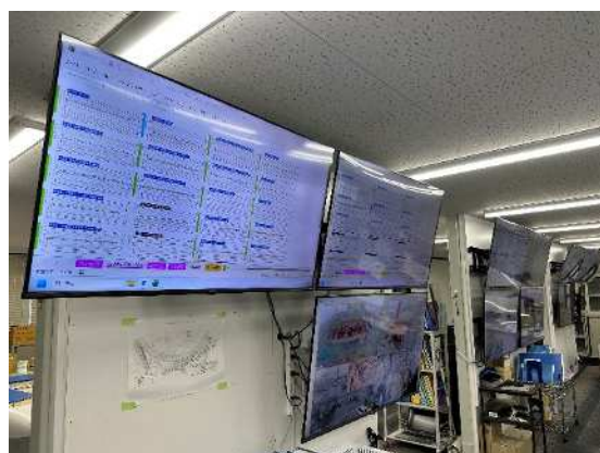
写真-5 現場事務所の計測データ 管理状況
