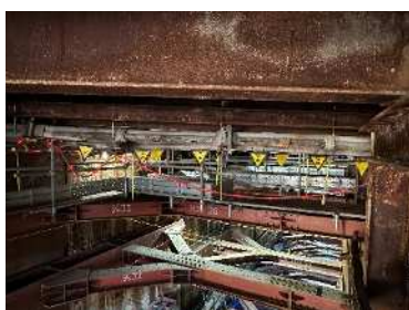
写真-1 NTT 吊り防護状況
