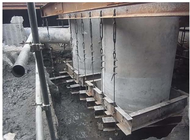
写真4 下水道人孔防護状況2
