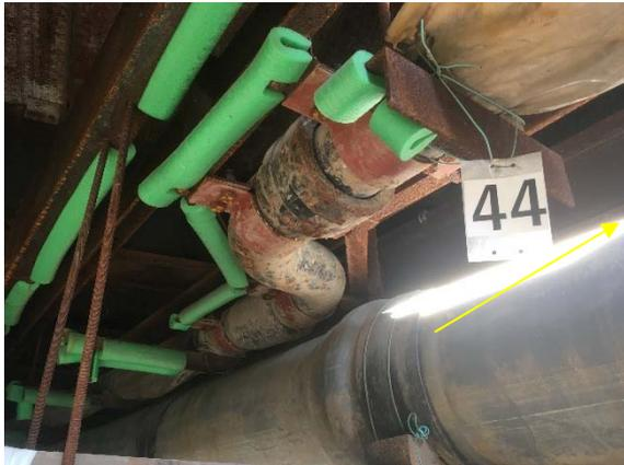
写真1 水道管抜出し防護設置状況
