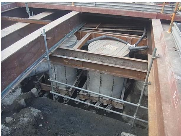
写真3 下水道人孔防護状況1
