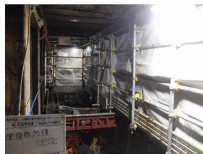
写真-12 開口部周囲防護養生設置状況
