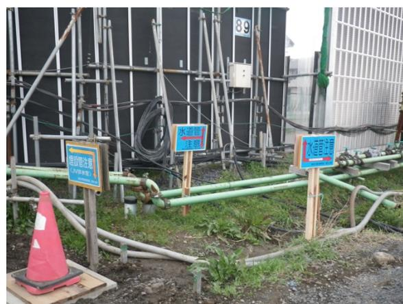
写真-2 埋設管注意標示板設置状況
