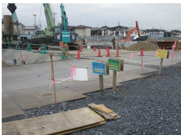
写真-1 埋設管注意標示板設置状況
