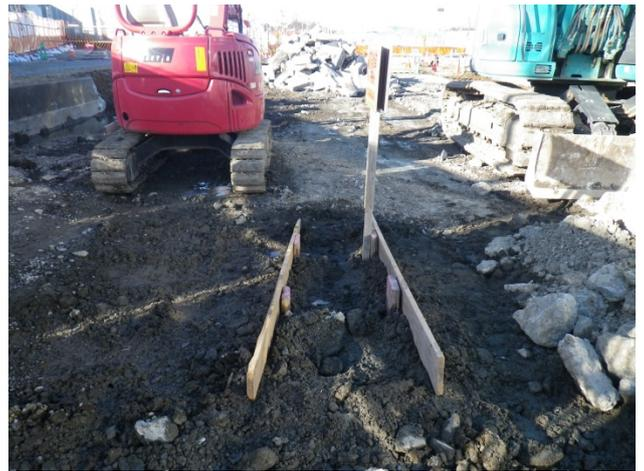
写真-3 地下埋設管位置明示状況
