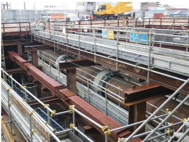
写真-4 φ1,100mm 水道管受け防護状況
