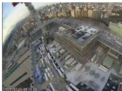
▲WEBカメラを活用して現場状況を確認
