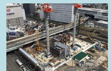
2021年7月 鉄骨工事開始
