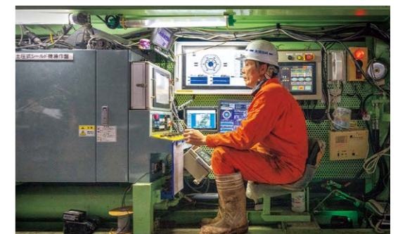
▲シールドマシンの進行方向を決めるジャッキは、自動で制御されるため、オペレーターの負担を軽減することができます
