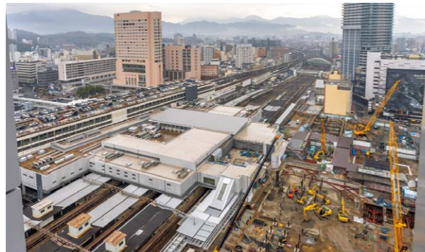
◀広島駅周辺では再開発が相次いでおり、広島駅の「陸の玄関口」は今まさに大きく変貌しようとしています。工事ではデフォルト(初期値)をとり、高架橋や既存施設への配慮も徹底しました。JRとも協議し、工事に伴う振動が軌道に影響を及ぼさないよう定点観測を行いながら進めています
