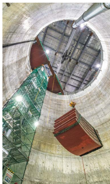
▲重量があるセグメントをクレーンを使って坑内へ。徹底した安全管理を実施しています
