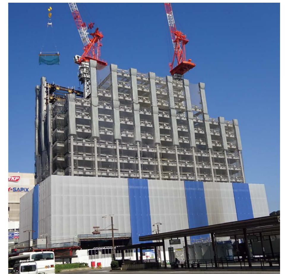
▲整然と並ぶ鉄骨溶接用ユニット式足場
