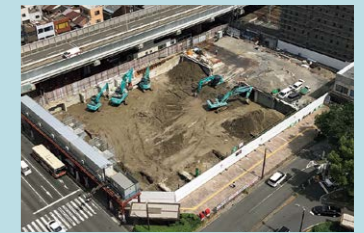
2020年8月 既存地下躯体の解体
