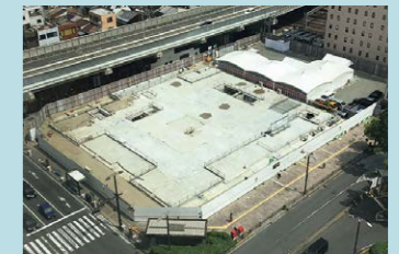
2020年6月 着工時状況
