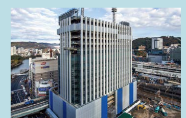
2021年12月 外装工事状況
