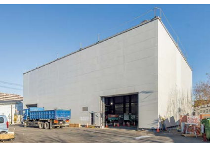
◀立坑の入口がある建物。工事の音が周辺へもれない効果があります
