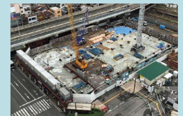
2021年6月 基礎工事完了
