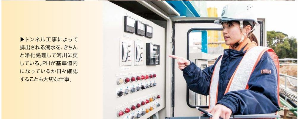
▶トンネル工事によって排出される濁水を、きちんと浄化処理して河川に戻している。PHが基準値内になっているか日々確認することも大切な仕事。
