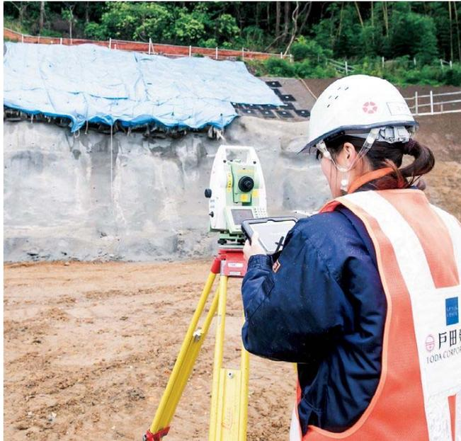
◀少しの誤差がトンネルの貫通精度に大きく関わってくるので慎重にかつ繰り返し測量をしていく。山岳トンネルのため、時には山の中に入って測量することもある。
