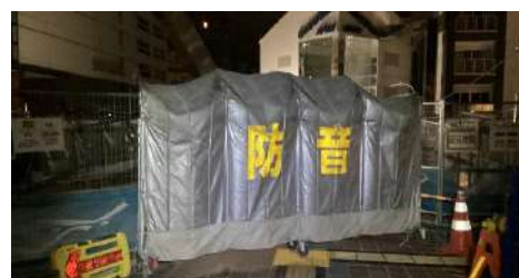
夜間施工箇所② 道路カッター 対策工: 一面防音
