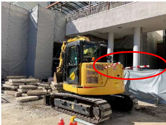
重機安全ポール取付
