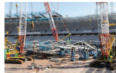
陸上競技場内で最終組み立てをして吊り上げられる屋根鉄骨
