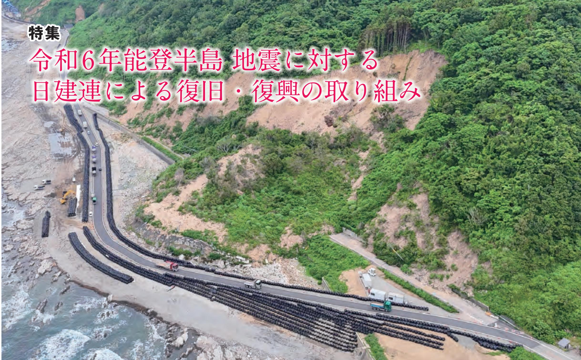
2024年7月2日撮影の国道249号白米千枚田付近。1車線の迂回路ができ緊急車両および地元住民の通行が可能となった(写真提供：国交省北陸地方整備局)
