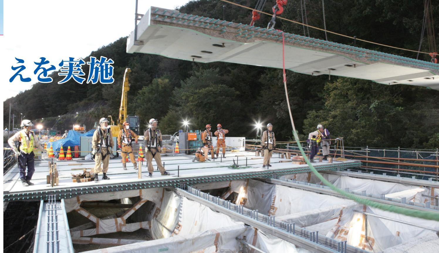
床版の設置。工場で製作したPCa床版は工期の短縮と高い耐久性を実現(沓掛橋)
