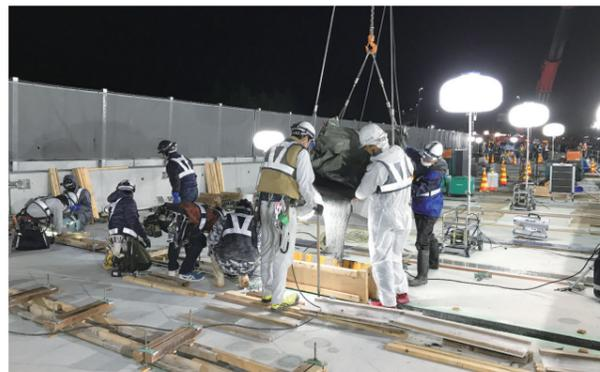
PCa床版同士の接合部分に超高強度繊維補強コンクリートを採用(沓掛橋)
