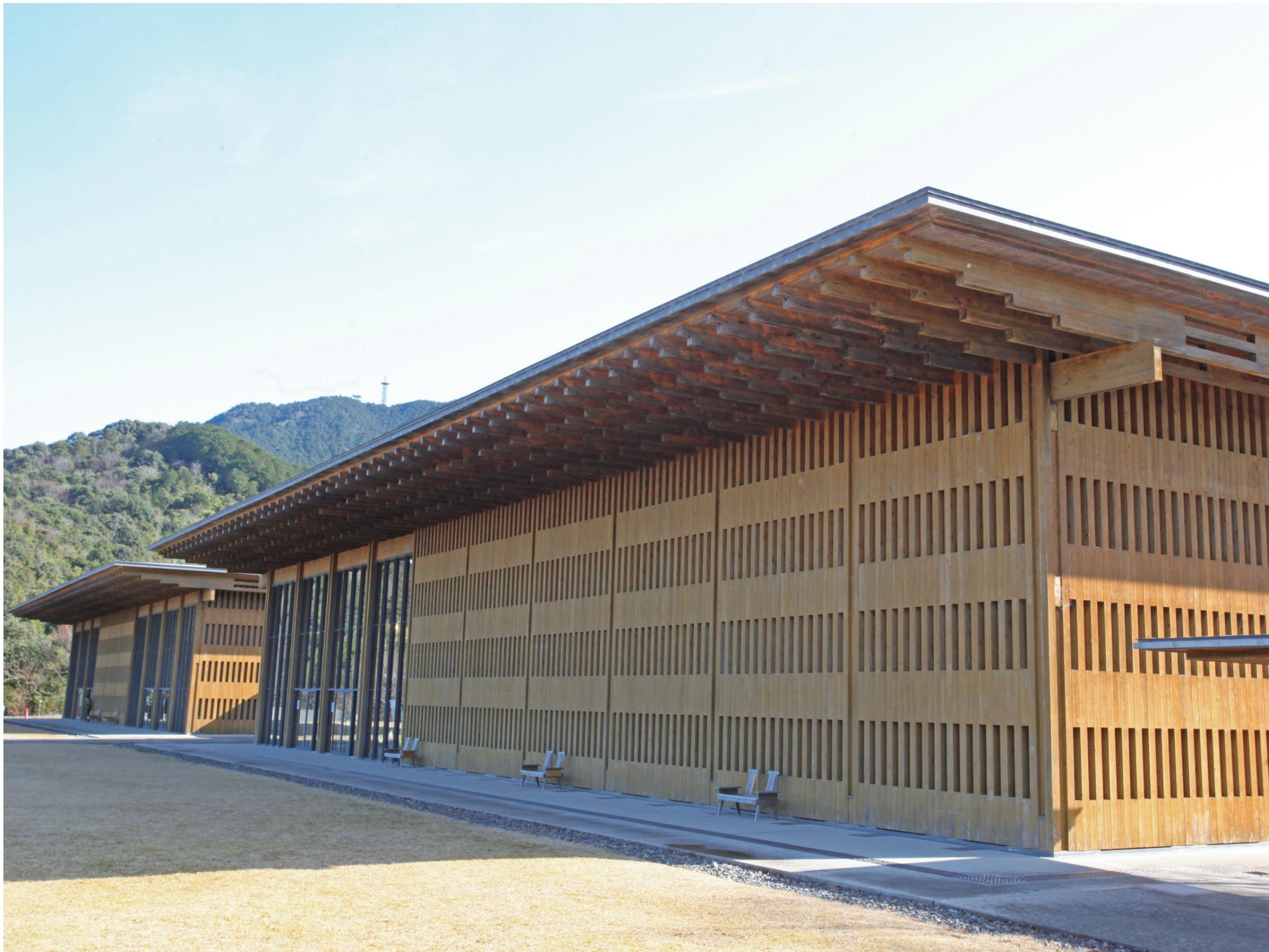
尾鷲湾を望む高台に建つ熊野古道センターは、木造平屋建ての展示棟と交流棟、鉄筋コンクリート造地上2階建ての研究収蔵棟からなる。2004(平成16)年、熊野古道が世界遺産に登録されたのを受け、情報発信と地域の交流拠点として2007年に開館した。構造材料となる木材は地場産の尾鷲ヒノキを使用し、その調達には全ての産地とかかわった業者などのトレーサビリティを明確にしている。木造建物は4.3mの深い庇、広い開口と天井高約7mの大空間が特徴的で、トラス架溝や集成材を使用せず、135mm角の尾鷲ヒノキの無垢材を組み合わせた等断面集積木材構造でつくられている。市場に流通している角材サイズにすることで、後の修繕補修時に木材調達がしやすくなる。使われた尾鷲ヒノキは60～80年生の6549本で、135mm角に製材後、数本ずつを束ね組柱、組梁、組壁をつくりそれを組み上げている。連続する立て格子の直線的な美しさや力強さだけでなく、木造ならではの経年変化もまた魅力の一つとなる。熊野古道を象徴する同センターは優れた建築作品として2008年にBCS賞、2012年に第13回公共建築賞などを受賞している。
