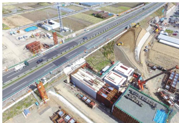
SFT工法による函体推進状況
