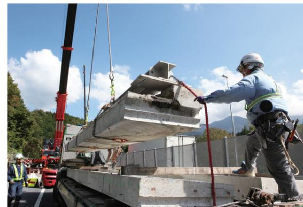
水平ワイヤーソーで切断した桁上床版の撤去(上田川橋)
