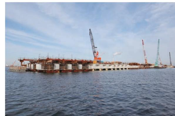
プレキャスト工法による構築が進む揚炭棧橋設置工事
