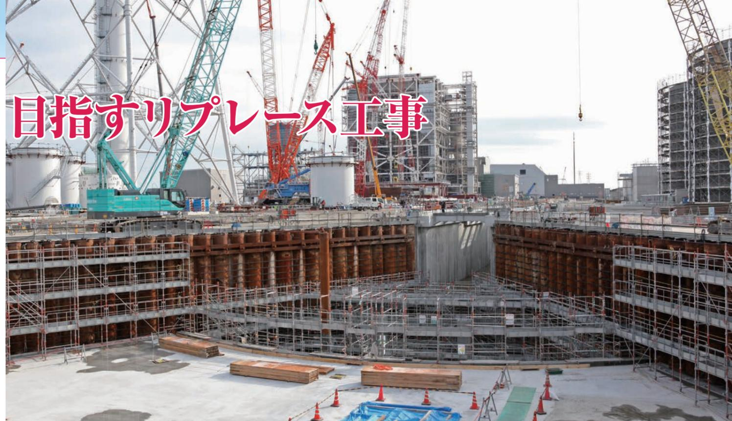
旧発電設備の放水口躯体も生かして新たな放水口設置工事が進む
