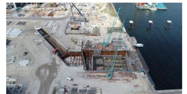
上から見た取水槽設置工と循環水管基礎設置工
