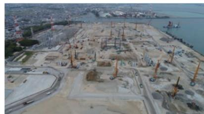
最大13台の杭打機が稼働した地盤改良工
