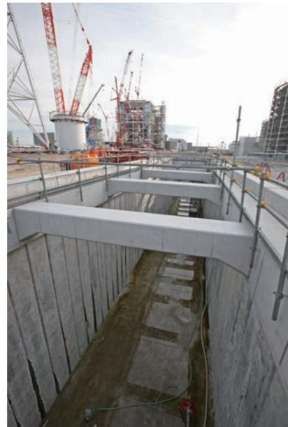
水路側面にPC-壁体を使用した放水路
