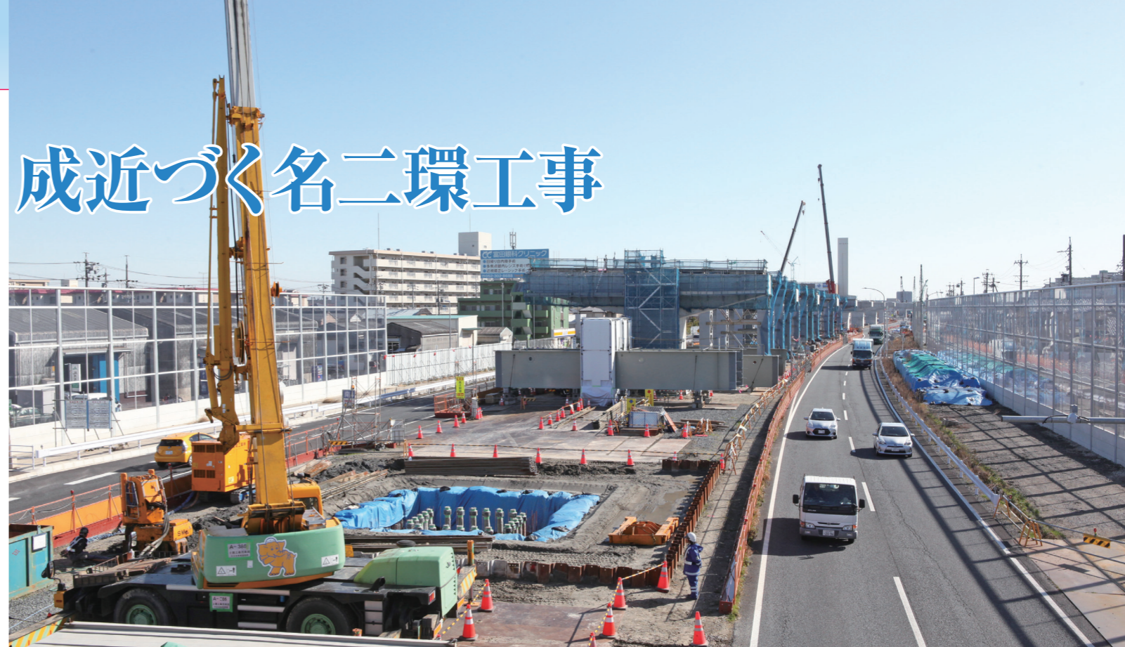
完成した橋脚が並び名古屋西 JCT。順次引き渡しが行われ上部工の工事に移る
