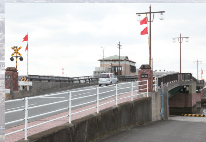
千歳運河に架けられた可動橋で、現在で3代目の臨港橋
