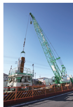
回転抗工法は施工機械がコンパクトで狭い工事現場に向いている
