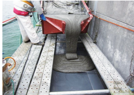
流し込むだけの現場打設の様子
