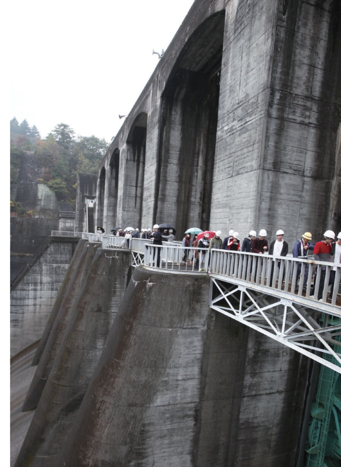
既設の丸山ダムの堤体上を歩く
