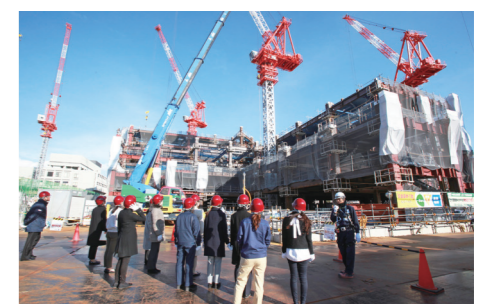
躯体工事が進む新小牧市民病院の建設現場
