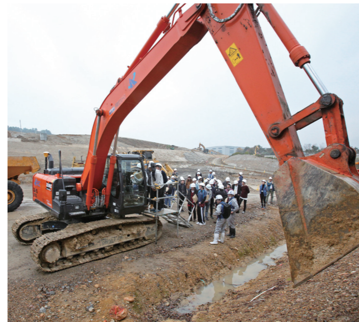
重機の大きさが現場の規模を物語る
