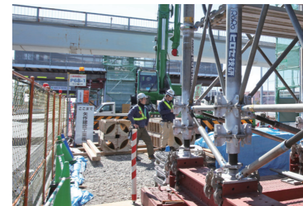
かの里工事現場は週休二日モデル工事として発注者とともに働き方改革に取り組んでいる
