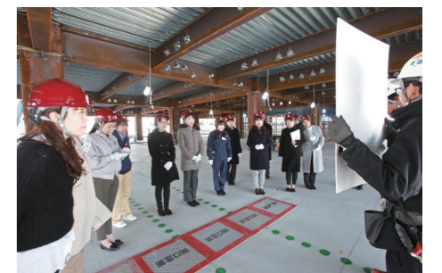
現場担当者から工程の説明を受ける
