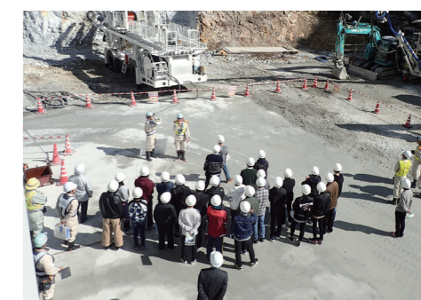
三遠道路3号トンネル新城地区工事(平成29年11月7日)
