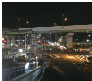
名古屋西 JCT で夜間に行われた切回し工事
