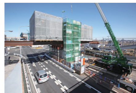
車道をまたぐかたちで特殊支保工が設置されたかの里1の橋脚
