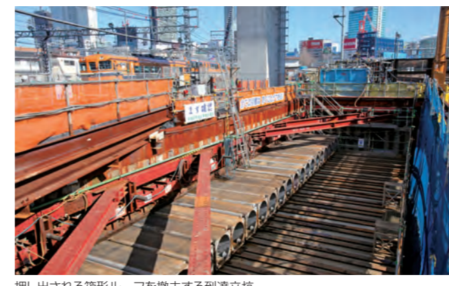
押し出される箱形ルーフを撤去する到達立坑
