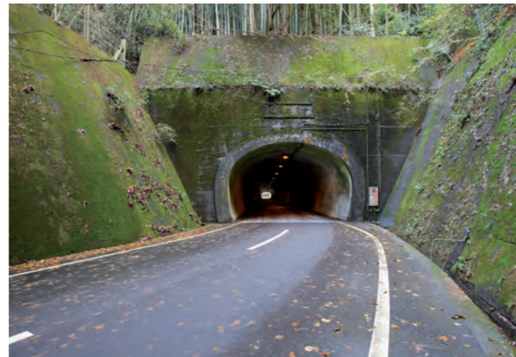
旧国道1号の大正のトンネル。現在は県道として利用されている
