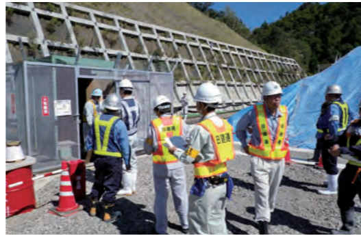
火薬類消費現場パトロール(平成26年10月7日)
