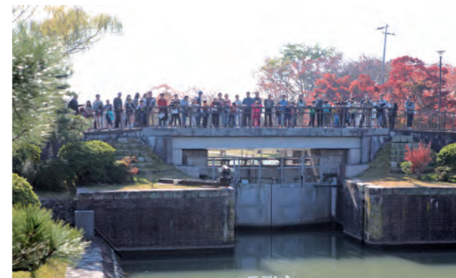
船頭平閘門の構造を体感する
