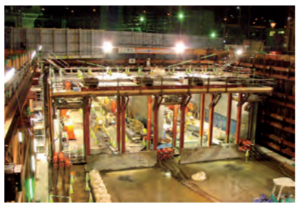
函体を圧入する夜間作業
