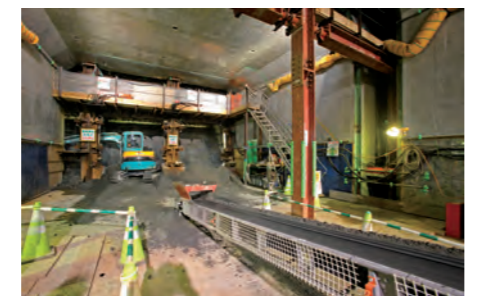
函体内でのトンネル掘削作業
