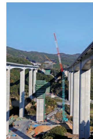
安楽川橋建設現場
