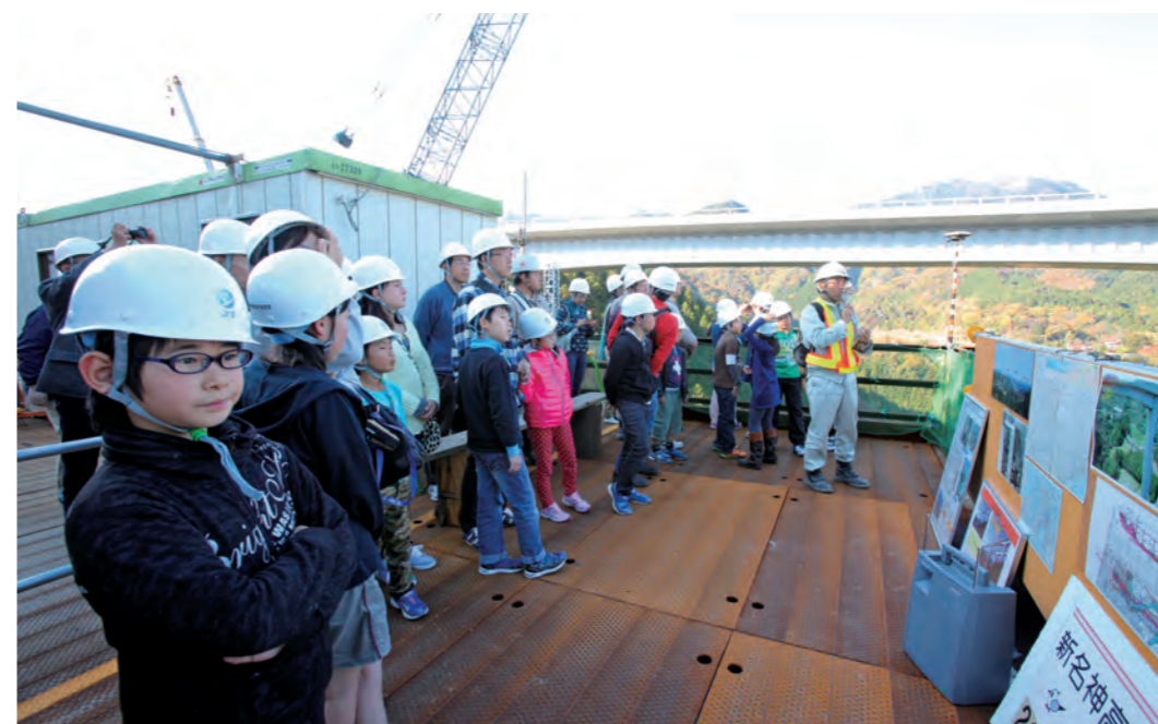
作業構台から説明を聞く(安楽川橋建設現場)
