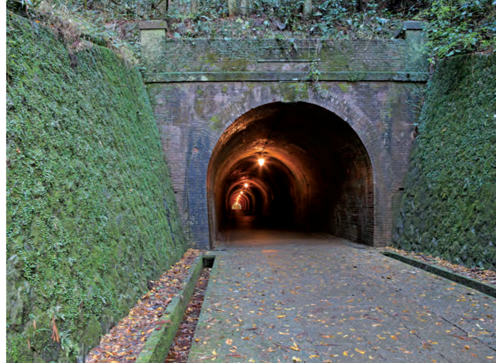
現在は遊歩道となっている明治のトンネル
