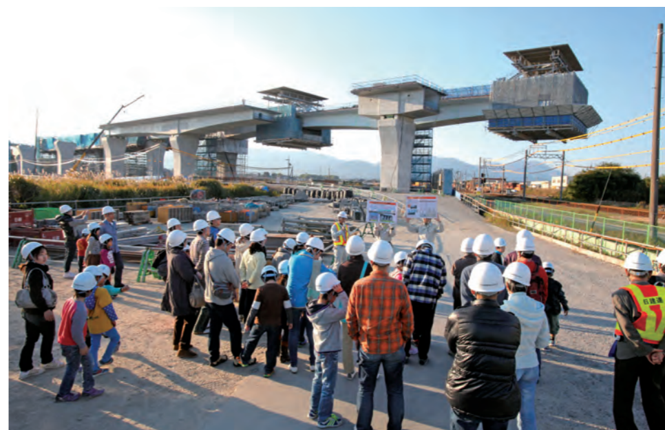
張出し架設工法で施工が進む(小牧高架橋建設現場)
