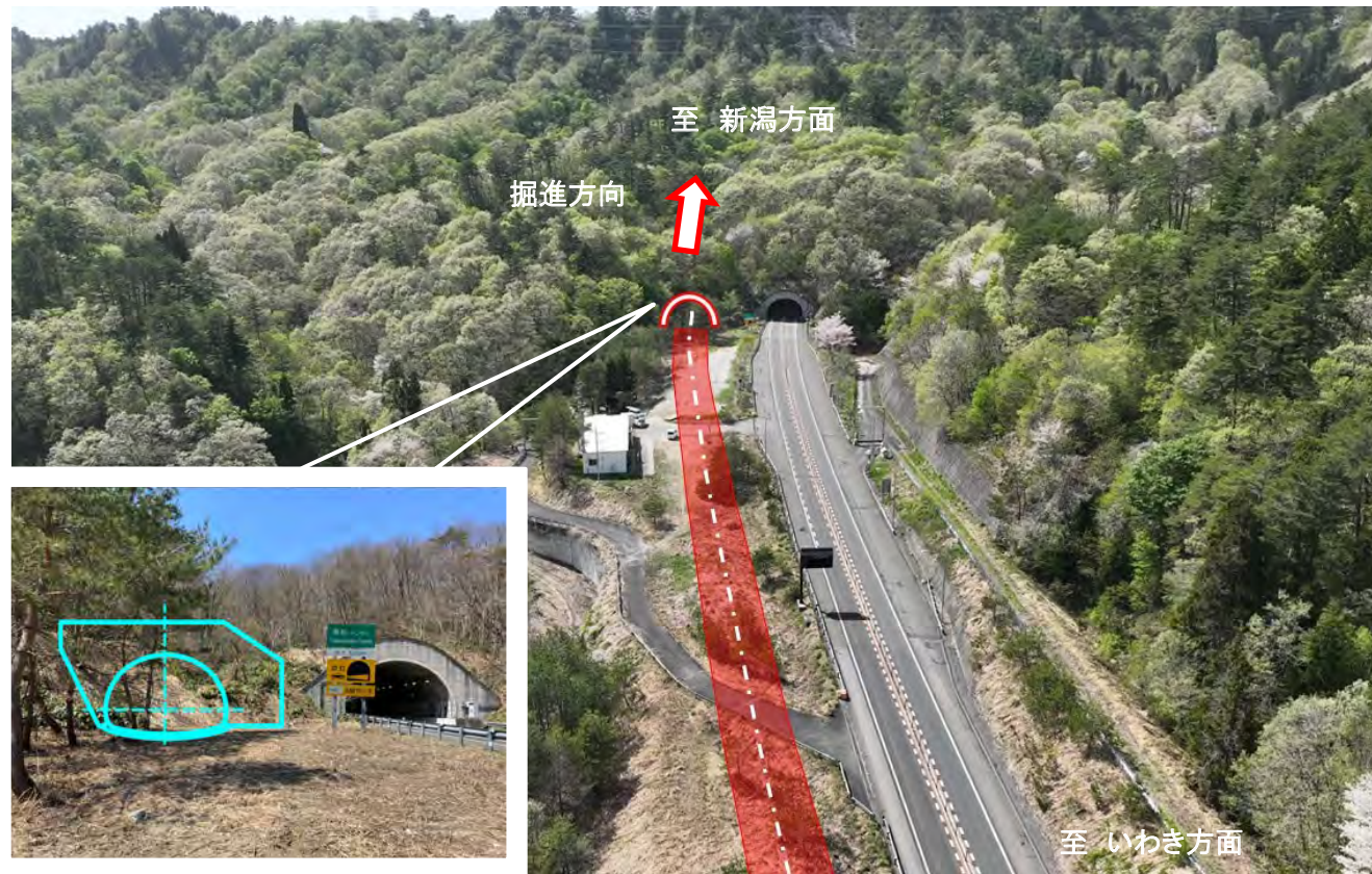
起点側坑口部着工前
