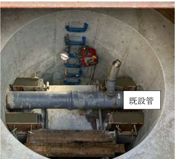
図1 分水人孔打設状況
