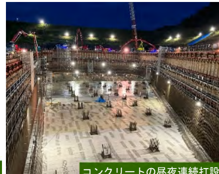
コンクリートの昼夜連続打設
