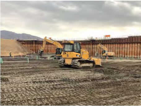
2.排水後に締切内を整地する
