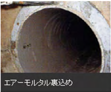
FRPM管設置写真 (参考)
