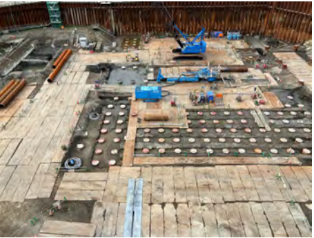
4.堰柱の支持杭を建て込む
