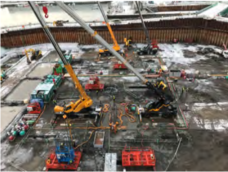
3.堰柱の地盤改良を行う
