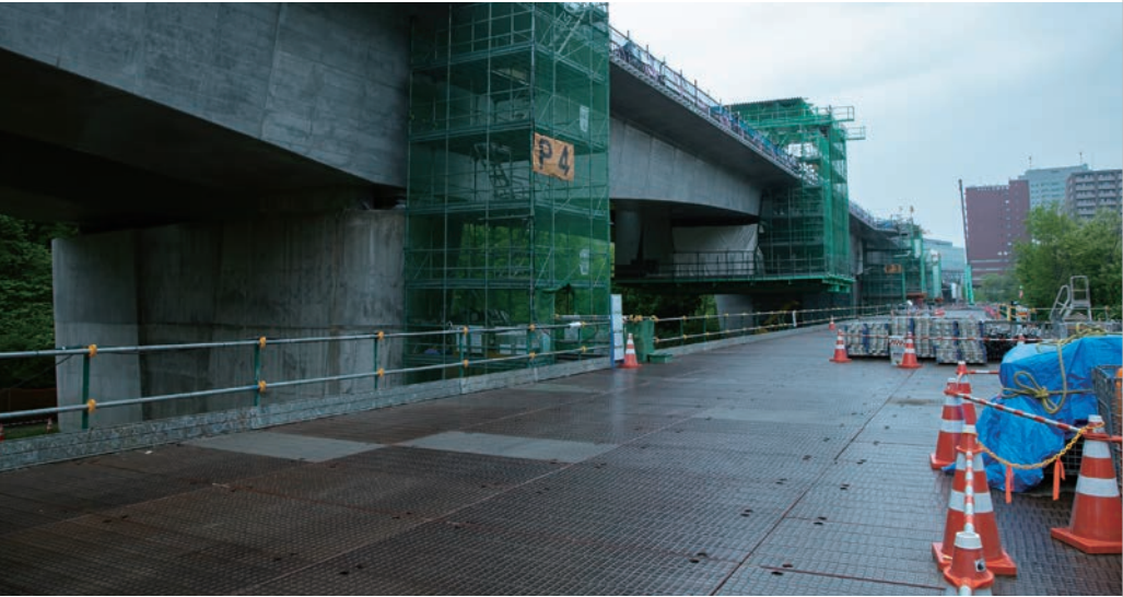
クレーンによる作業などを行うための仮設栈橋。現地の過去10年の水位記録を調査し、最高水位から1mほど高い所に設置されている。
