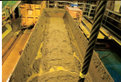
シールドマシンを所定の深さ約20mの地下へと運び、工事をスタートさせるための発進立坑。シールド工によって削った土が、次々と運び出される。
