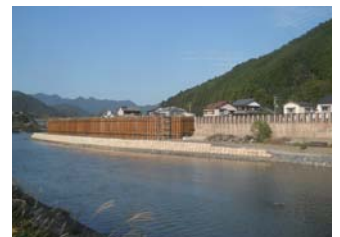
二重締切(仮復旧)下流側全景 23.10.28
