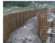
タイロッド設置作業 23.10.22
