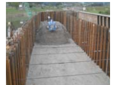
中詰工(上段タイロッド設置)作業 23.10.4
