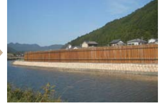
復旧後全景写真 鋼矢板による二重締切(仮復旧)完了 23.10.28
