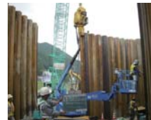
バイプロハンマによる鋼矢板打設作業 23.9.25
