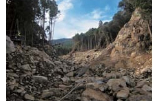
被害状況(第二堰堤付近) 23.11.4
