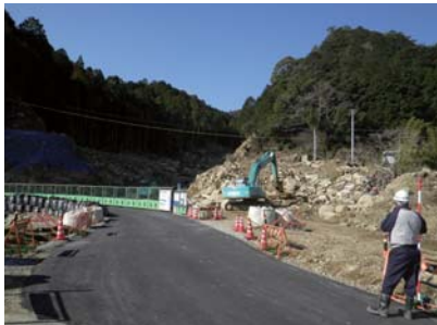
第二堰堤工事状況 24.2.27
