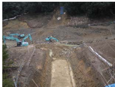
第一堰堤工事状況 24.2.25
