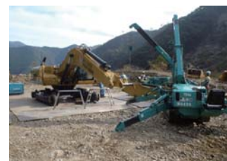
仮排水路掘削状況 23.10.20
