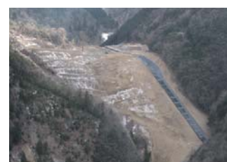
仮排水路掘削状況 24.2.1
