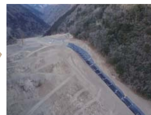
復旧状況(堤頂部、斜面部仮排水路) 24.2.1
