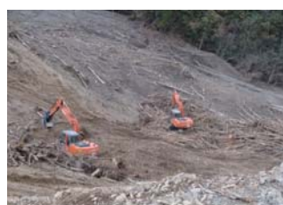
倒木伐採状況→堤頂部仮排水路 23.10.25
