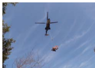
ミニバックホウ(0.1m 3 級)空輸状況 23.10.9
