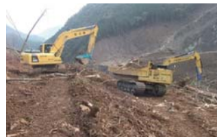
倒木撤去状況 23.10.25
