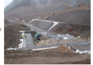
対策工事の状況 24.3.2
