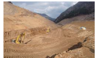
仮排水路掘削状況 23.12.12
