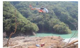
発電機搬入(ヘリコプター使用) 23.9.29
