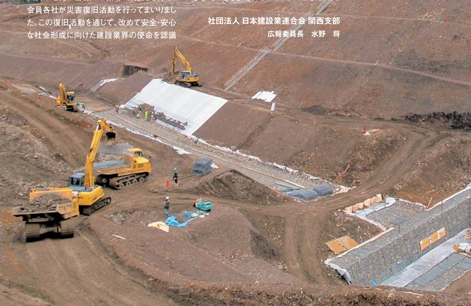
仮排水路工事(赤谷) 24.3.3
