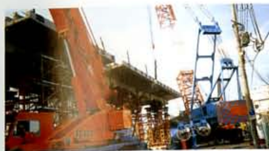
重機械による復旧状況
