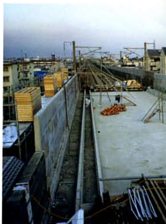
軌道工事引き渡し
